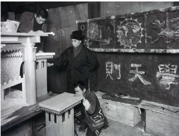
写真3. 作業現場と思われる写真 [6]
